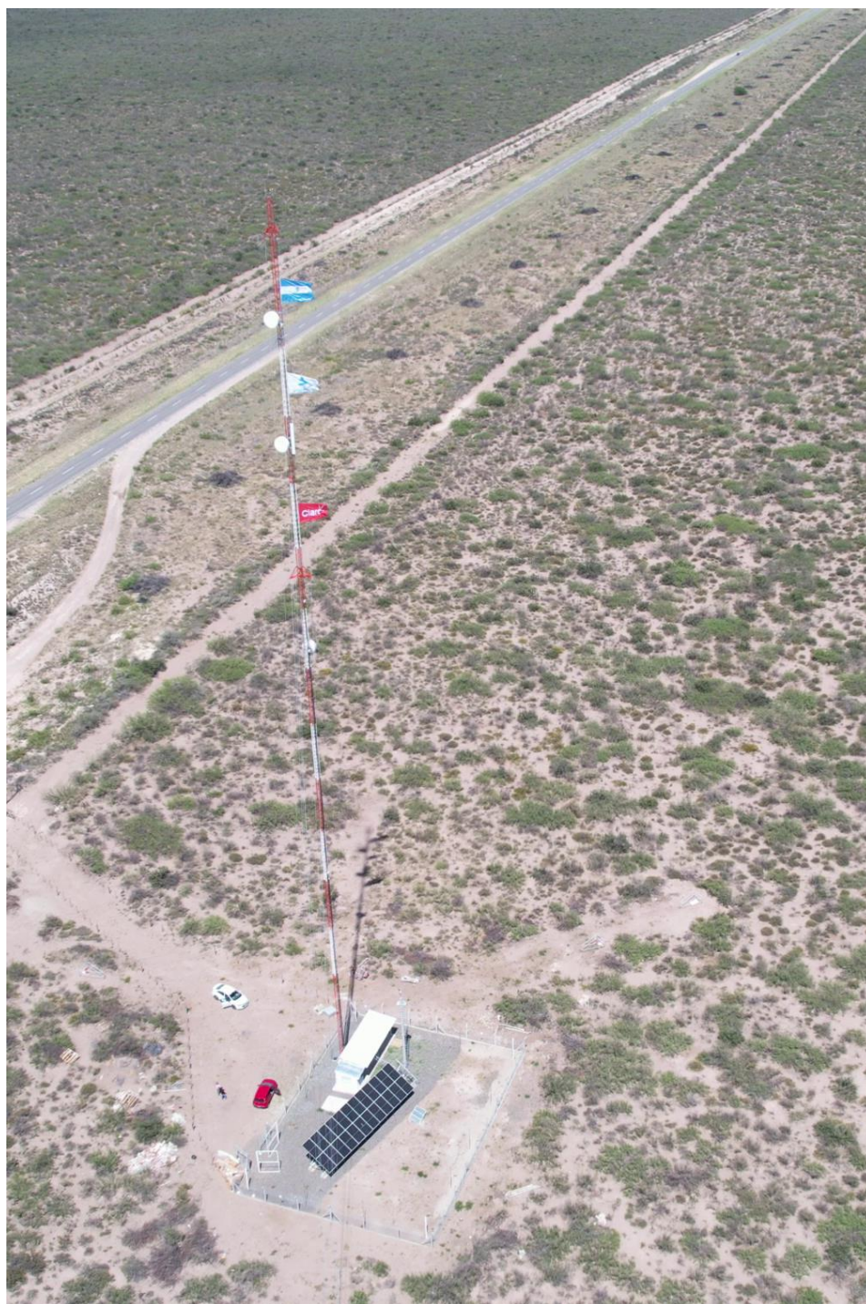
Torre "Punto D", ubicada a la vera de la ruta provincial n°20
